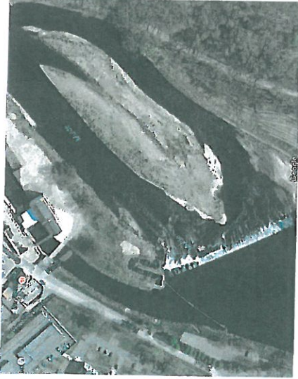
9. Wehr Großmühle Grömma (Luftbild Google)
