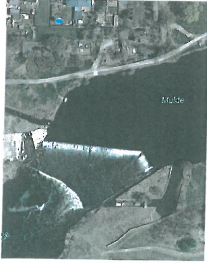
6. Wehr Wurzen (Luftbild Google)
