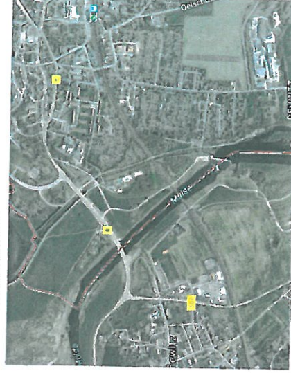
6. Wehr Wurzen (Luftbild Google)
