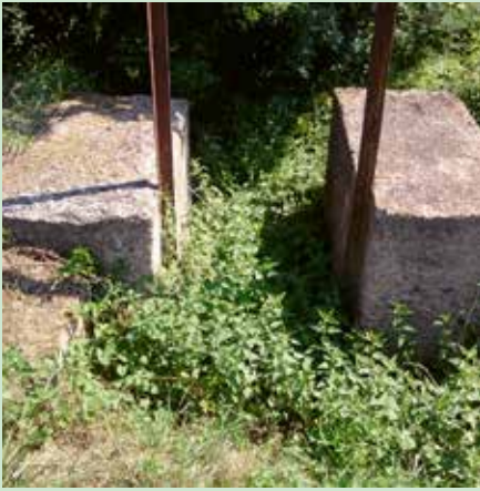
Einlaufbauwerk mit Führungsschienen für Stautafel ins Gewässer 43/025
