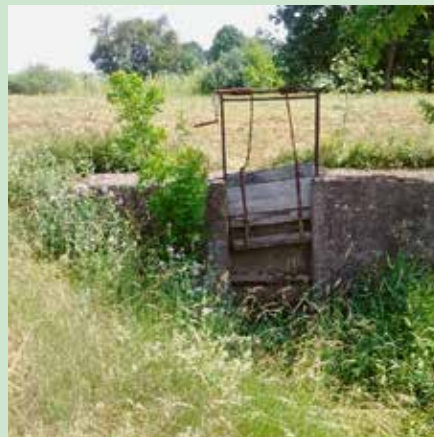
Einlaufbauwerk von der Helme in Gewässer 53/093
