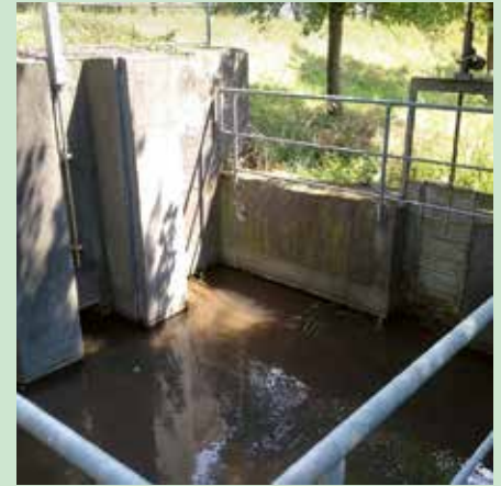
Einlaufbauwerk mit Führungsschienen für Stautafel ins Gewässer 43/025
