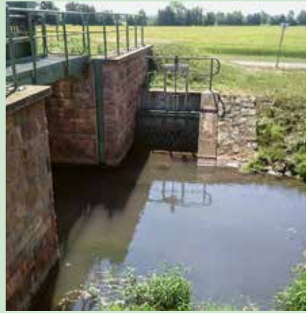
Einlaufbauwerk in Gewässer 43/051 aus 43/Mühlgraben
