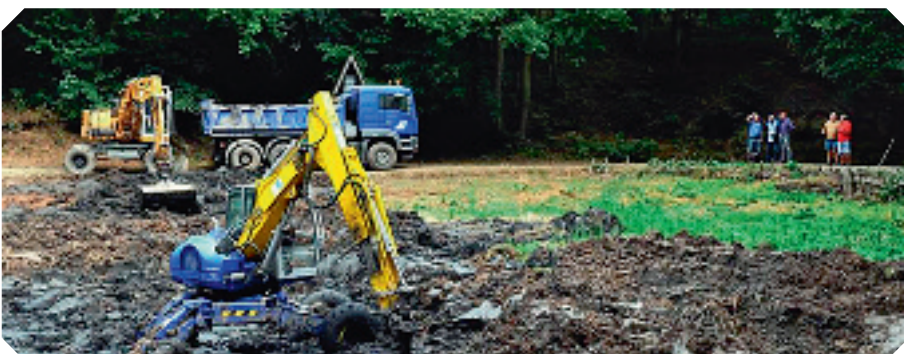
Beseitigung des eingeschwemmten Schlammes am Mönchsteich
