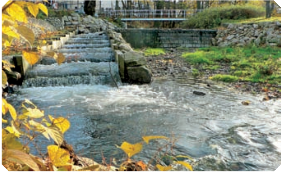
Neue Fischauftiegsanlage, rechts das alte Wehr
