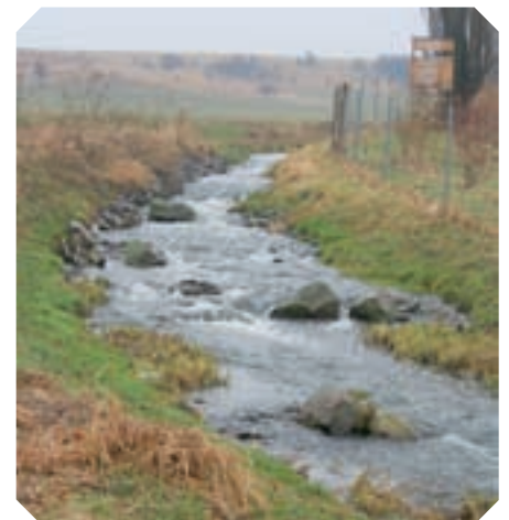
Sohlgleite in der Aller für den ungehinderten Fischwechsel
