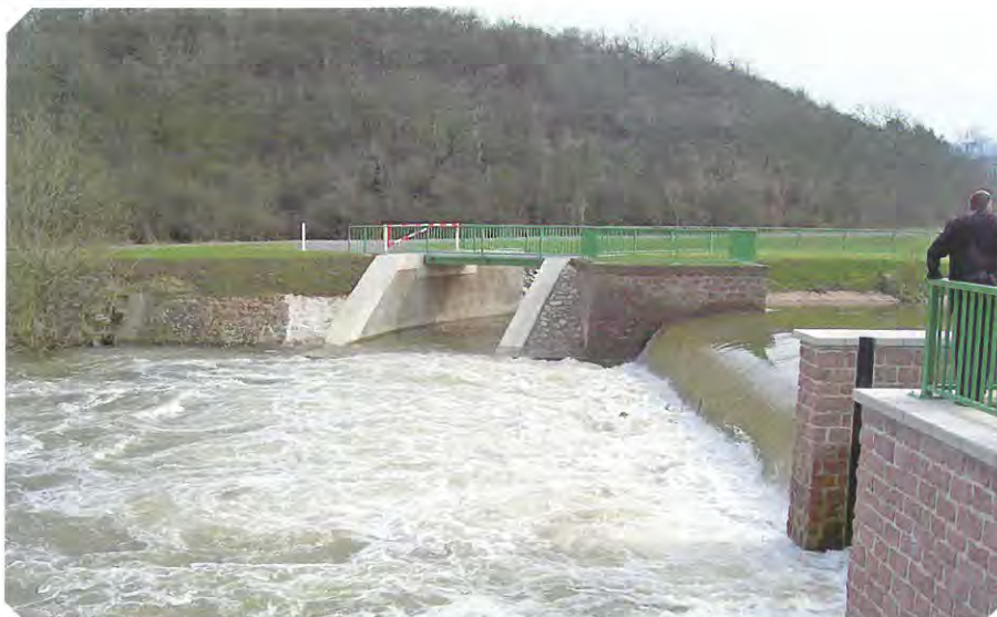
Sanierte Wehranlage mit Fischpass
