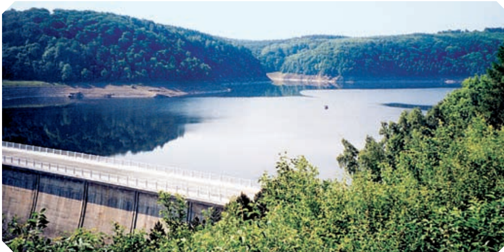
Talsperre mit Staumauer
