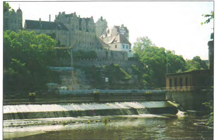
Bernburger Wehr bei Niedrigwasser. Am Wehr befindet sich eine Fischtreppe. Dort ist das Angeln verboten
