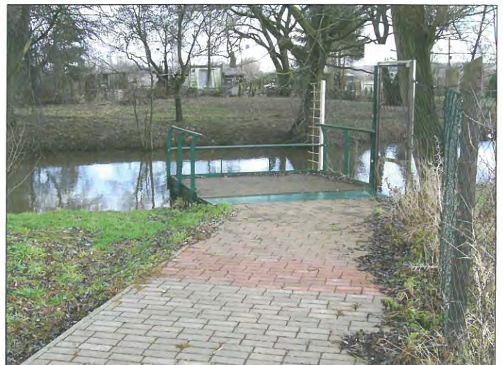
Am Altarm in Rossla wurde mit Hilfe des Kreissportbundes Sangerhausen und der Gemeinde eine rollstuhlgerechte Zufahrt geschaffen
